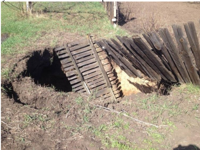
Рис. 1. Провал почвы над наклонным стволом шахты «Игнатьевская»
